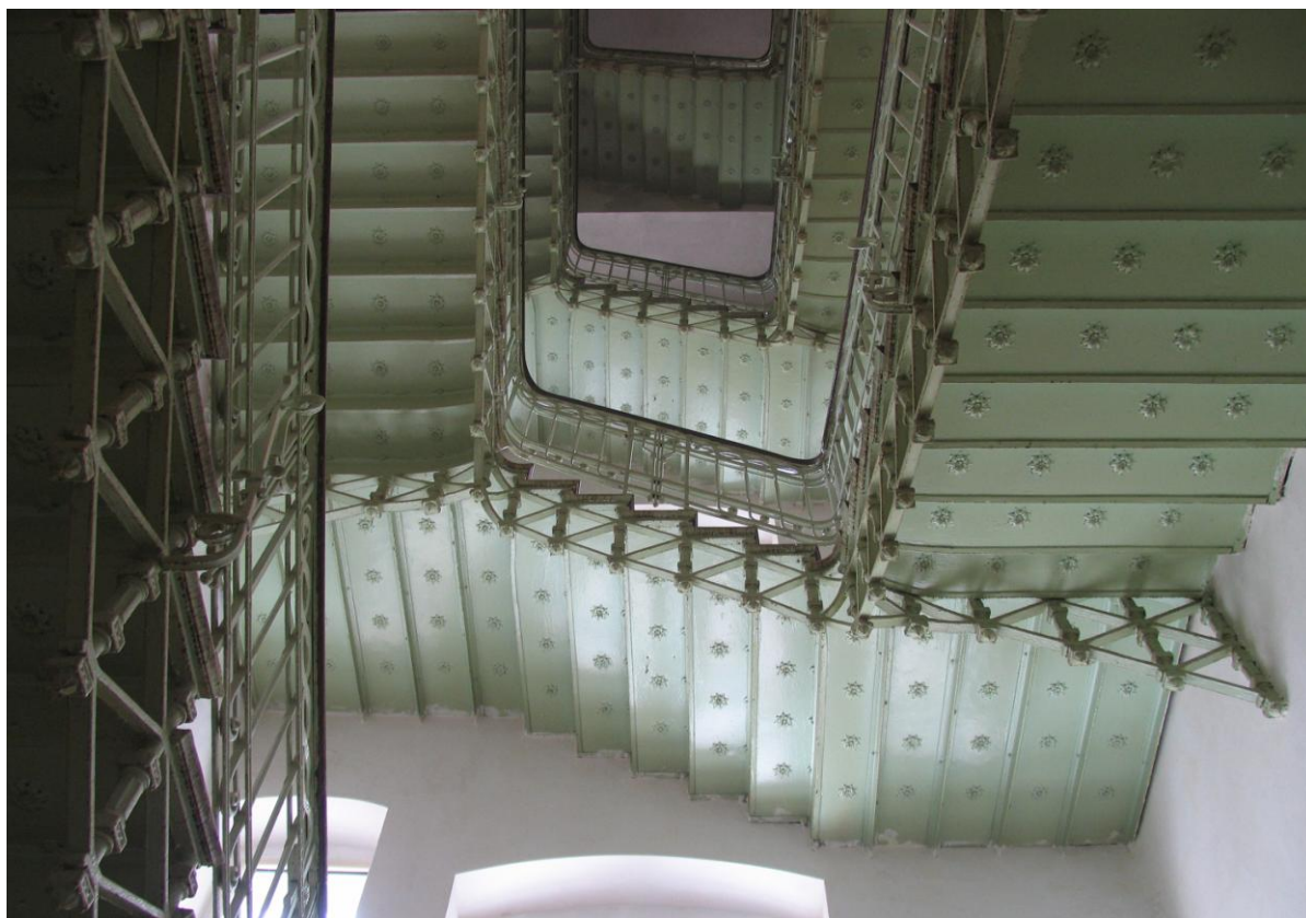
Fot. 1. Schody głównej klatki schodowej dawnego sanatorium przeciwgruźliczego
