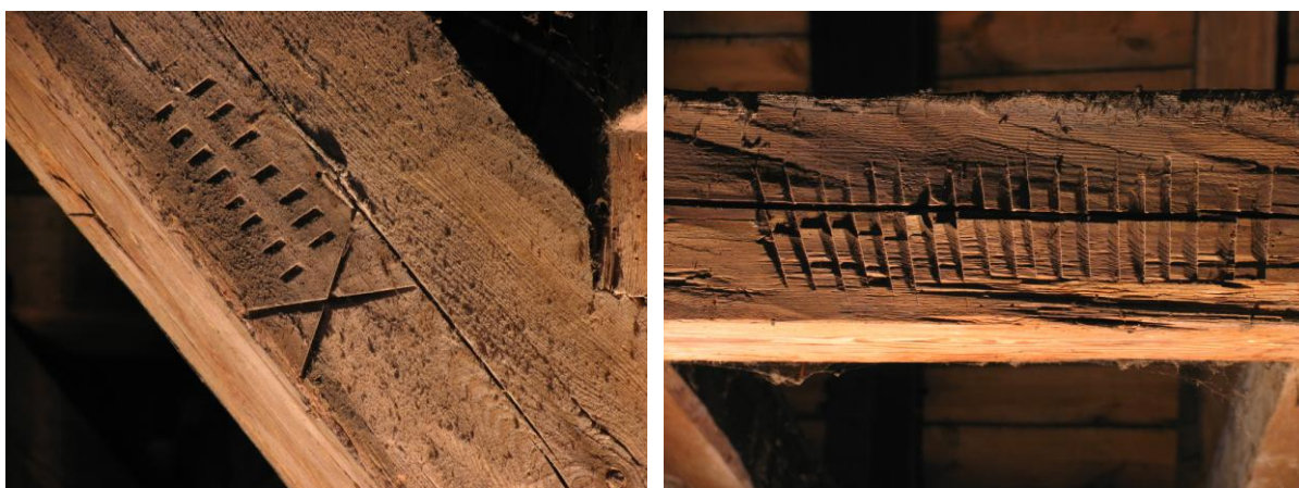
Fot. 4-5. Różne typy ciesielskich znaków montażowych więźby dachowej północnego skrzydła zamku
