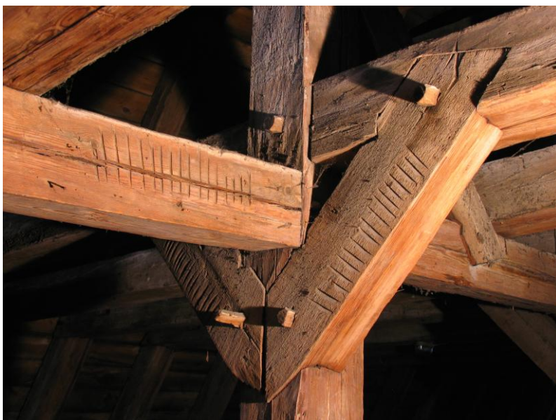
Fot. 3. Połączenia ciesielskie i znaki montażowe więźby dachowej północnego skrzydła zamku
