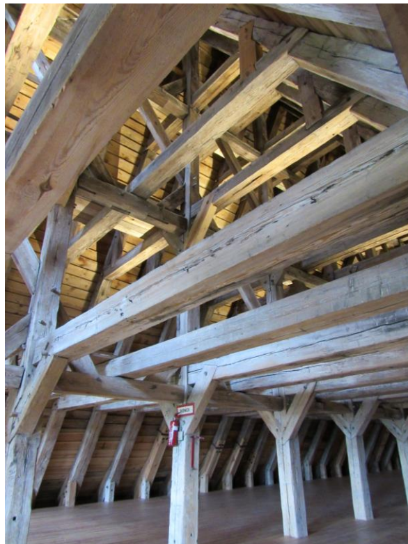
Fot. 1-2. Gotycki szczyt północnego skrzydła zamku i oryginalna konstrukcja więźby dachowej z około 1373 r.
