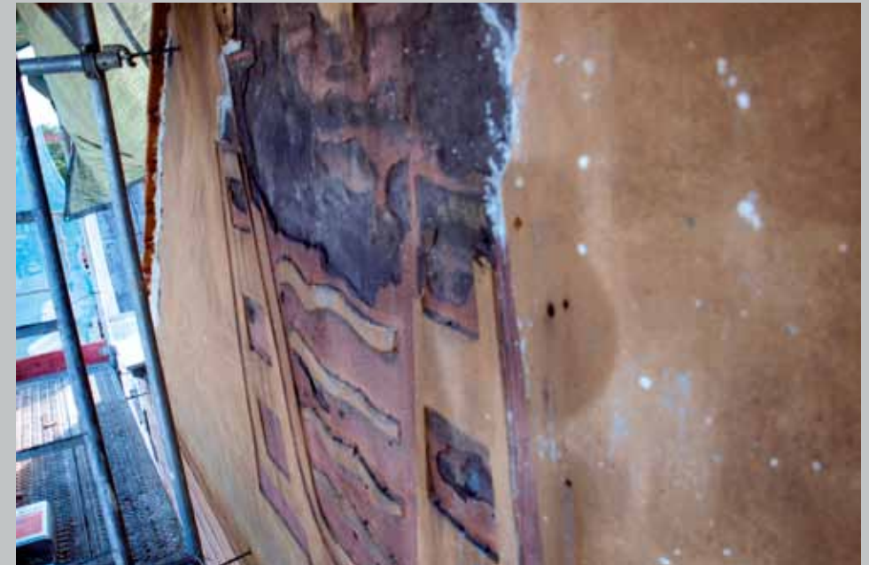
11. Rok 2012. Stan w trakcie prac, zakończony etap podklejania i wzmacniania symbolu kina w szczycie elewacji. Fot. D. Pestka-Bajer
