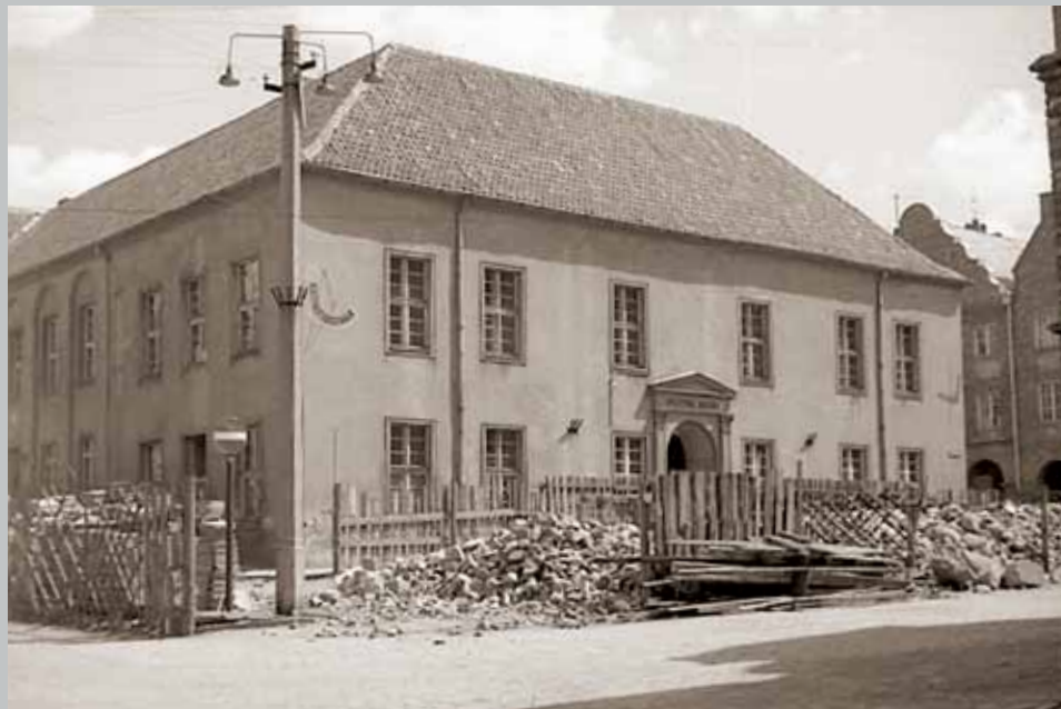
2. Odbudowany po wojnie Stary Ratusz w Olsztynie (1948–1950) – skrzydło południowe. Fot. J. Żurawski, 1957; źródło: zbiory Archiwum WUOZ w Olsztynie
