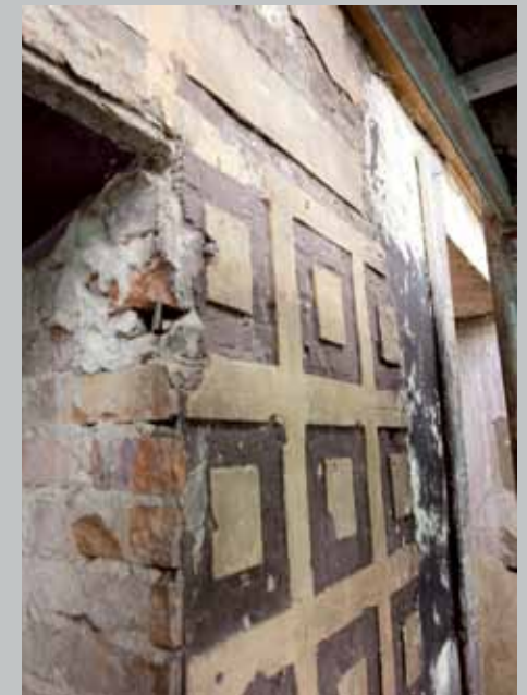
12. Rok 2012. Strefa parteru. Odsłonięta dekoracja spodnia sgraffita dwukolorowego. Fot. D. Pestka-Bajer
