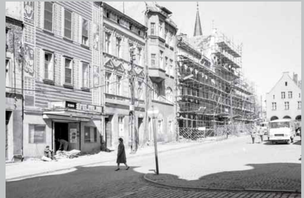
1. Zachodnia pierzeja rynku wiosną 1965 r. Na pierwszym planie widoczny budynek kina Awangarda z istniejącą już pierwszą wersją sgraffita. W głębi rusztowania wzdłuż elewacji, których dekoracje zaprojektowane i zrealizowane zostały przez M. Szymańską, E. Kochanowskiego, H. Oszczakiewicza i B. Wolskiego. Fot. Z. Grabowski; źródło: Archiwum Muzeum Warmii i Mazur w Olsztynie
