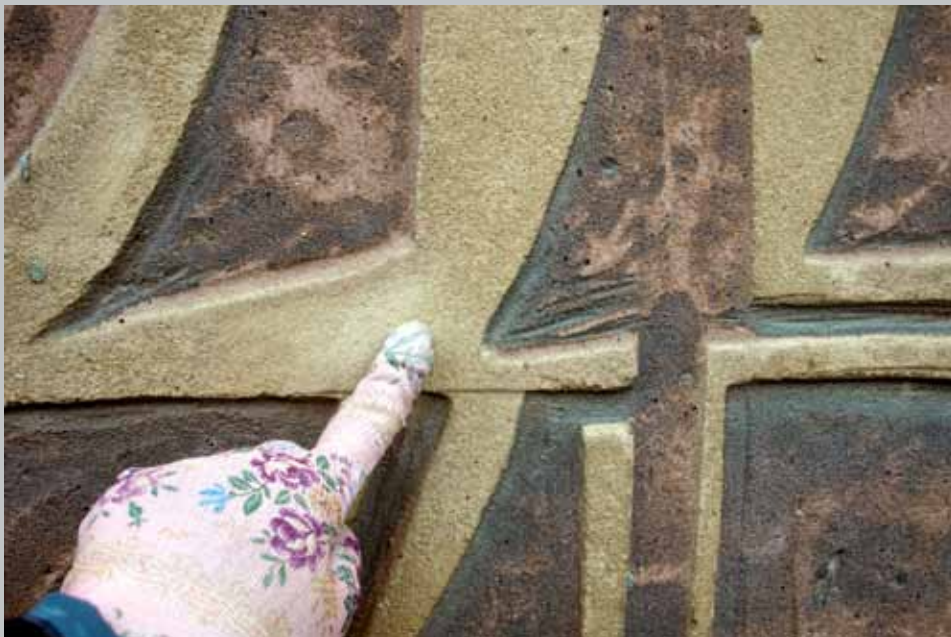
13. Rok 2012. Stan przed pracami konserwatorskimi. Widoczne ślady narzędzia prowadzone swobodną, wprawną ręką. Fot. D. Pestka-Bajer
