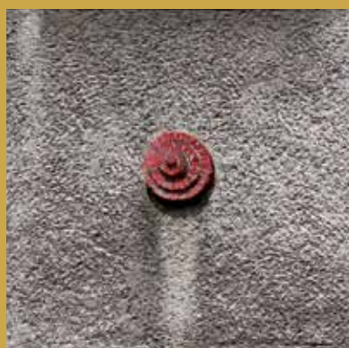
Stare Miasto 11/16 (elewacje od ulicy Staszica) Płaskorzeźby: Ryszard Wachowski, 1966
