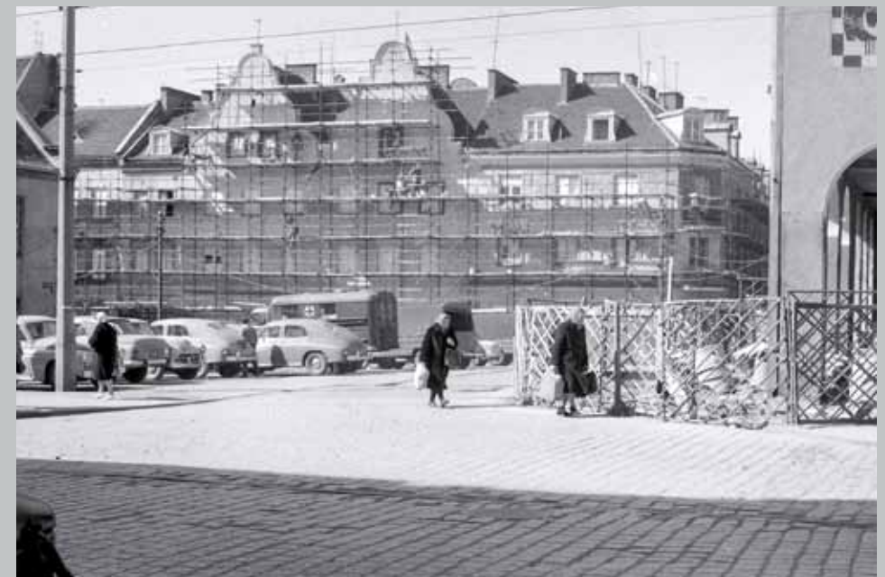
2. Zachodnia pierzeja rynku wiosną 1965 r. Dzięki fotografii prześledzić można kolejność opracowywania elewacji. Widoczne są wykonane już profile gzymsów, opaski otworów okiennych oraz tynk podkładowy. Nie ma jeszcze sgraffit. Fot. Z. Grabowski; źródło: Archiwum Muzeum Warmii i Mazur w Olsztynie
