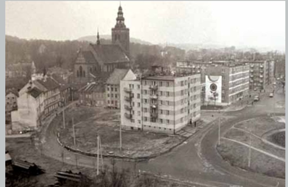
8. Lidzbark Warmiński, widok z wieży zamku na południowo-zachodnią część starego miasta. Fot. Z. Dąbkowski, PKZ Gdańsk; źródło: R. Wilimiński, M. Pawlisz, Studium rewaloryzacji. Analizy przestrzenne ważniejszych fragmentów. Śródmieście , t. 1, Olsztyn 1983 [mps], Archiwum WUOZ w Olsztynie
