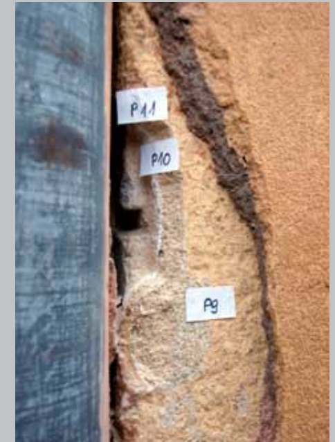
7. Rok 2012. W trakcie badań na elewacji. Odkrywka przy rynnie z lewej strony elewacji. Widoczne ślady zapraw z fazy II (neoklasycystycznej) i fazy III (modernistycznej). Fot. D. Pestka-Bajer
