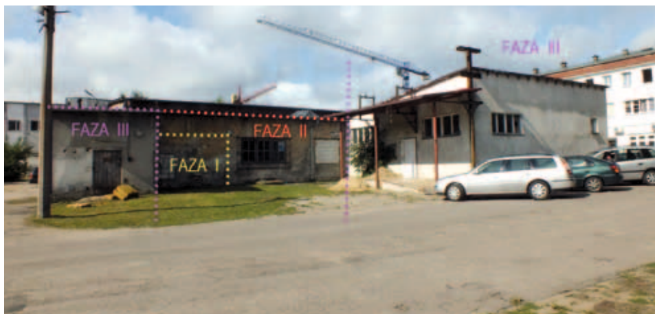
Fot. 5. Widok elewacji północnej z podziałem na poszczególne fazy budowlane, lipiec 2013 r.
