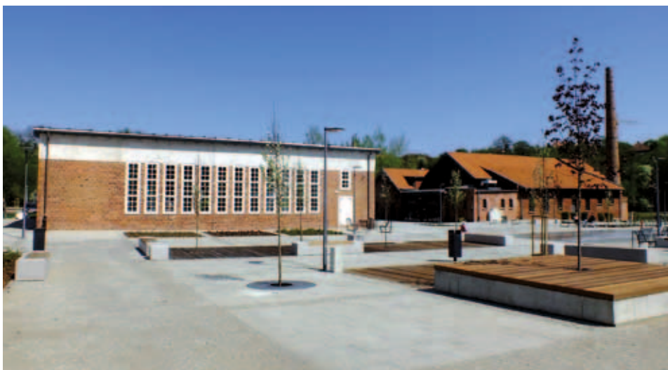
Fot. 1. Ogólny widok zespołu budynków Muzeum Nowoczesności w Olsztynie. Po lewej – wyremontowany budynek dawnej zajezdni trolejbusowej; po prawej – widoczny budynek dawnego tartaku Raphaelsohnów, kwiecień 2019 r.
