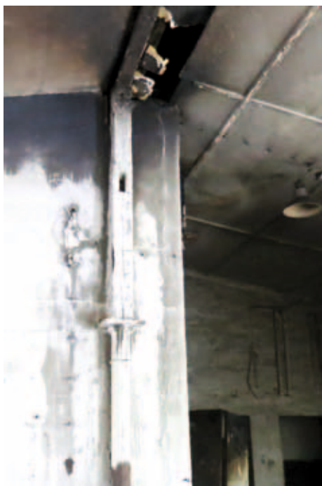
19. Fragmenty pierwotnej ramy stolcowej w hali dla bydła. Widoczne po lewej: gniazdo po usuniętym mieczu, słup drewniany oparty na pierwotnej żelaznej kolumnie; po prawej – zachowany miecz. Fot. D. Filipecka
