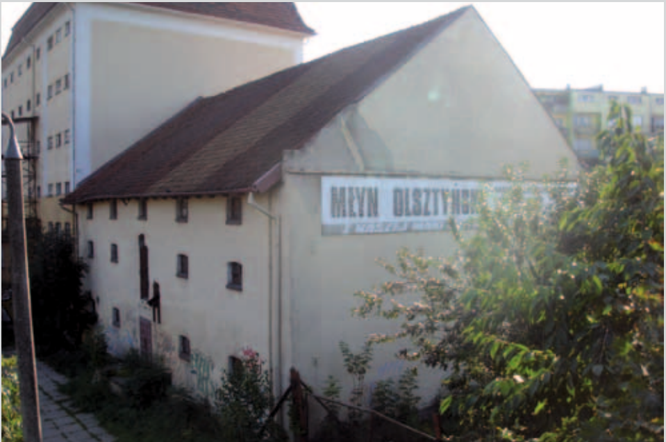
Widok na zespół zabudowy młyna od strony torów kolejowych (elewacje północno-wschodnie), sierpień 2018 r. Fot. J. Derewońko-Milewicz
