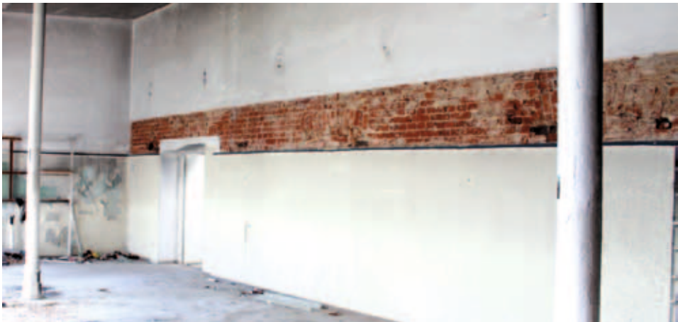
16. Odkrywka badawcza uwidaczniająca nadproża otworów w ścianie zewnętrznej od strony dziedzińca pierwotnego założenia budynku. Fot. B. Danilewicz
