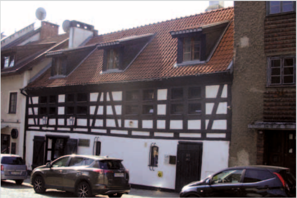
Spichlerz przy ul. Kołłątaja 14, elewacja frontowa (wschodnia), sierpień 2018 r. Fot. J. Derewońko-Milewicz
