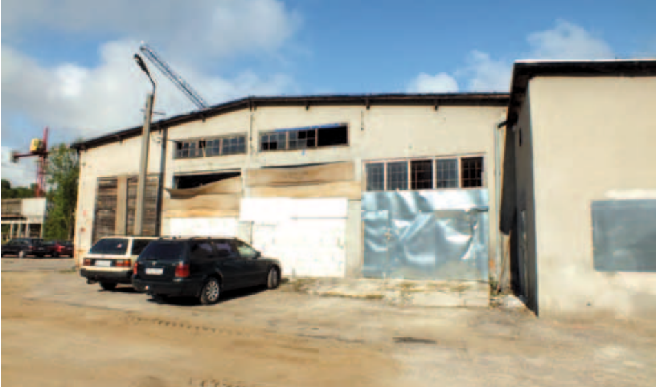
Fot. 2. Widok wschodniej elewacji budynku, lipiec 2013 r.
