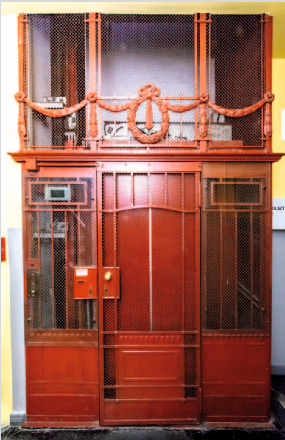
Obudowa szybu windowego na parterze klatki schodowej kamienicy przy pl. Jana Pawła II 2/3. Fot. M. Kierul
