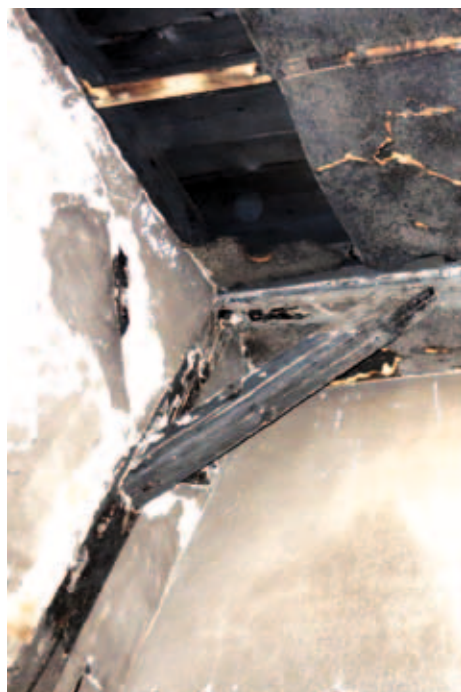
19. Fragmenty pierwotnej ramy stolcowej w hali dla bydła. Widoczne po lewej: gniazdo po usuniętym mieczu, słup drewniany oparty na pierwotnej żelaznej kolumnie; po prawej – zachowany miecz. Fot. D. Filipecka
