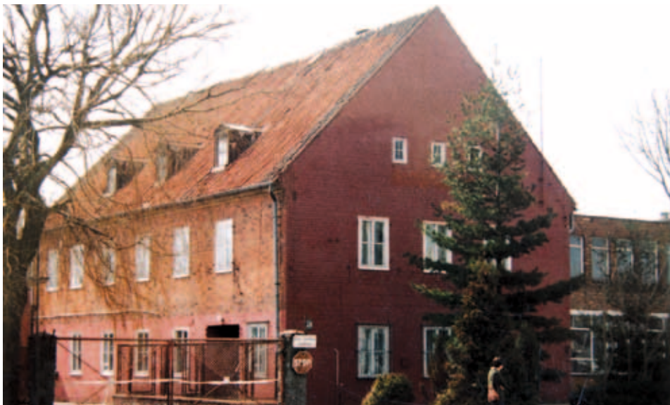
Dawny budynek administracyjny rzeźni w okresie likwidacji zakładu (stan z 2002 r. , obecnie nie istnieje). Fot. J. Liżewski
