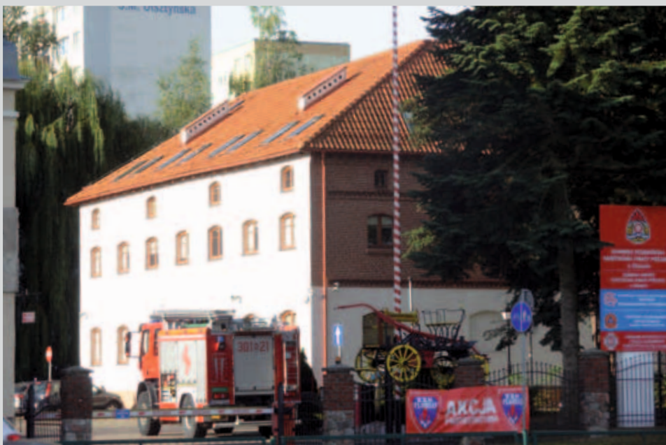
Elewacja podwórzowa (południowo-wschodnia) dawnego spichlerza przy ul. Niepodległości 12, sierpień 2018 r. Fot. J. Derewońko-Milewicz
