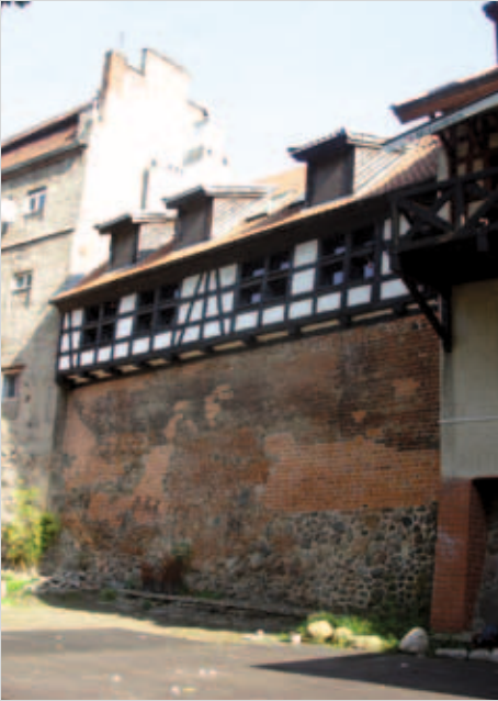
Spichlerz przy ul. Kołłątaja 14. Elewacja tylna (zachodnia), sierpień 2018 r. Fot. J. Derewońko-Milewicz
