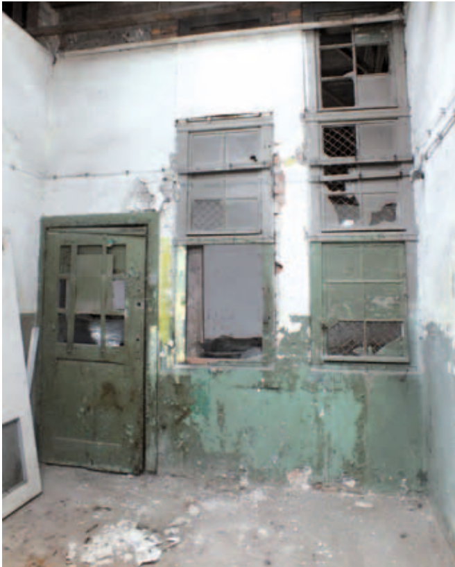
Fot. 3. Widok pierwotnie północnej elewacji zajezdni – późniejsze wnętrze dobudówki. Ponad linią wtórnego sufitu widoczny pierwotny wystrój nietynkowanej elewacji. Zdjęcie wykonane w lipcu 2013 r.
