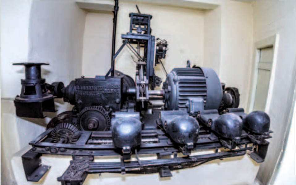
Wyposażenie maszynowni windy. Fot. M. Kierul
