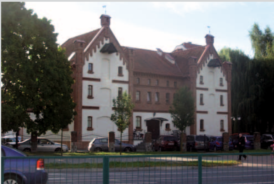
Elewacja frontowa (północno-zachodnia) dawnego spichlerza przy ul. Niepodległości 12, sierpień 2018 r. Fot. J. Derewońko-Milewicz
