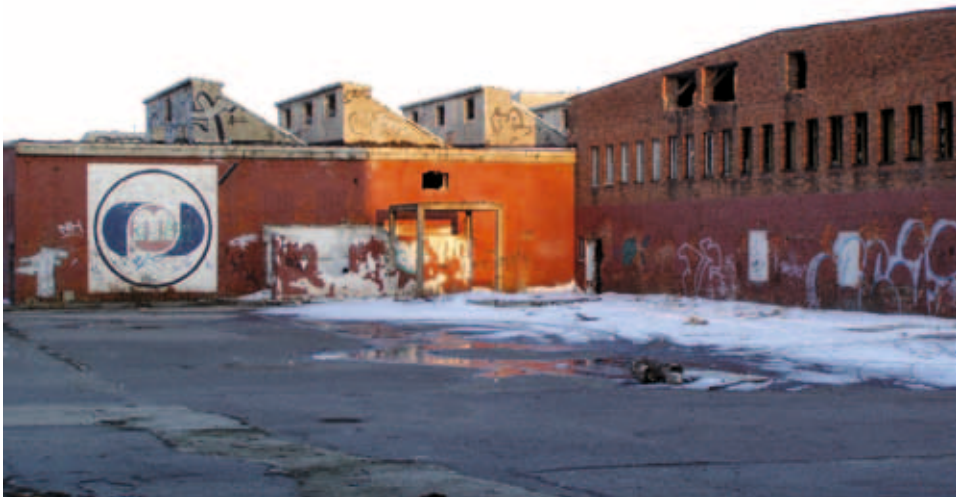
Hala główna dawnej rzeźni z widocznymi współczesnymi przemurowaniami (stan z 2003 r., obecnie budynki nie istnieją). Po lewej – oficjalne logo Zakładów Mięsnych w Olsztynie. Zdjęcie udostępnione przez stronę www.moje-fotografie.olsztyn.pl
