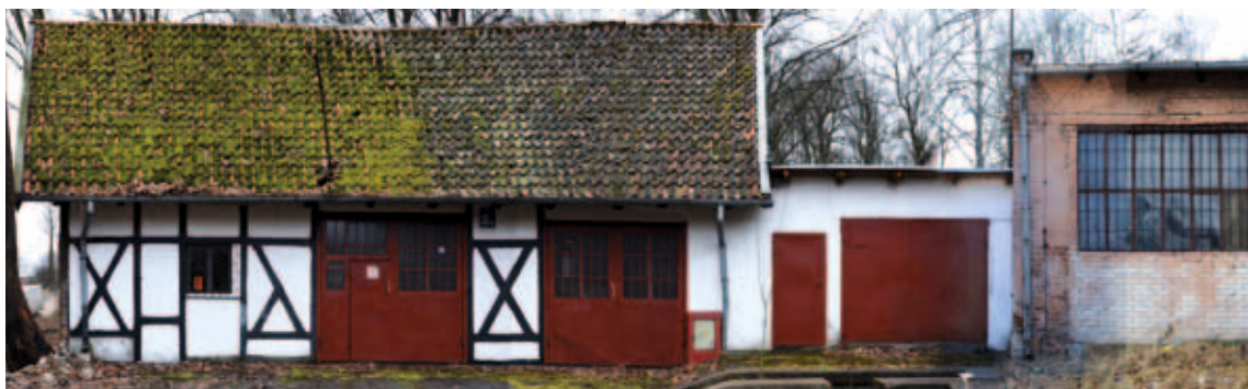
18. Elewacja północna zespołu budynków rzeźni. Od lewej: stajnia, współczesny łącznik, dawna obora. Widoczna znaczna degradacja elewacji, luty 2018 r. Fot. D. Filipecka
