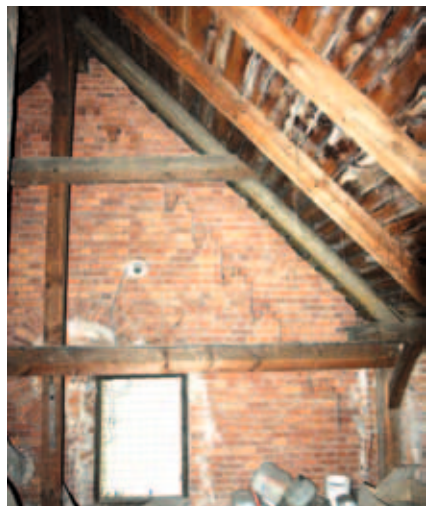
16. Odkrywka badawcza uwidaczniająca nadproża otworów w ścianie zewnętrznej od strony dziedzińca pierwotnego założenia budynku. Fot. B. Danilewicz
