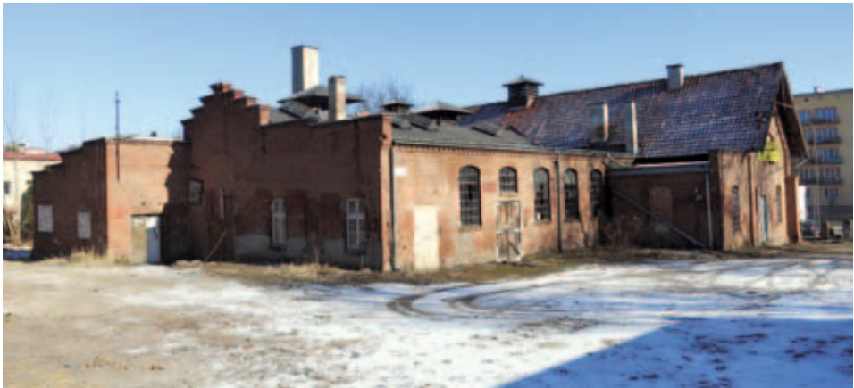
15. Budynek dawnej hali uboju, styczeń 2018 r. Fot. B. Danilewicz
