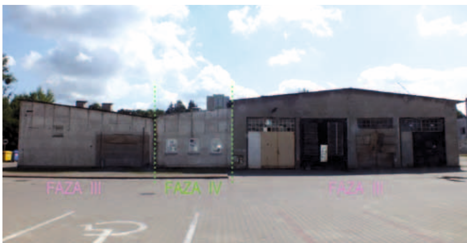
Fot. 4. Widok elewacji zachodniej z podziałem na poszczególne fazy budowlane, lipiec 2013 r.
