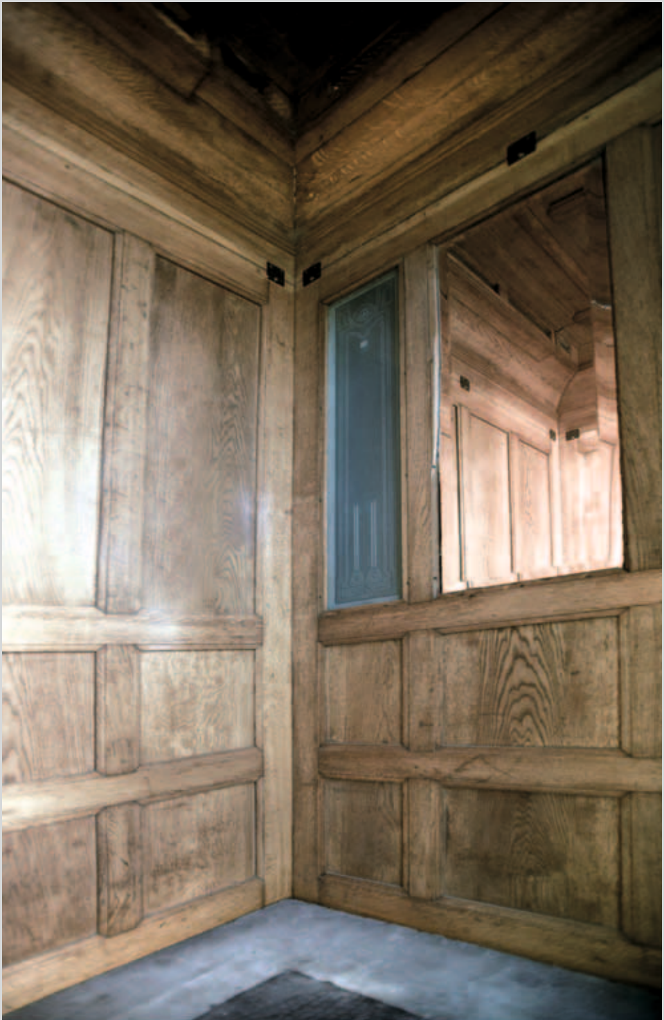
Fragment wnętrza drewnianej kabiny. Fot. P. Tutka
