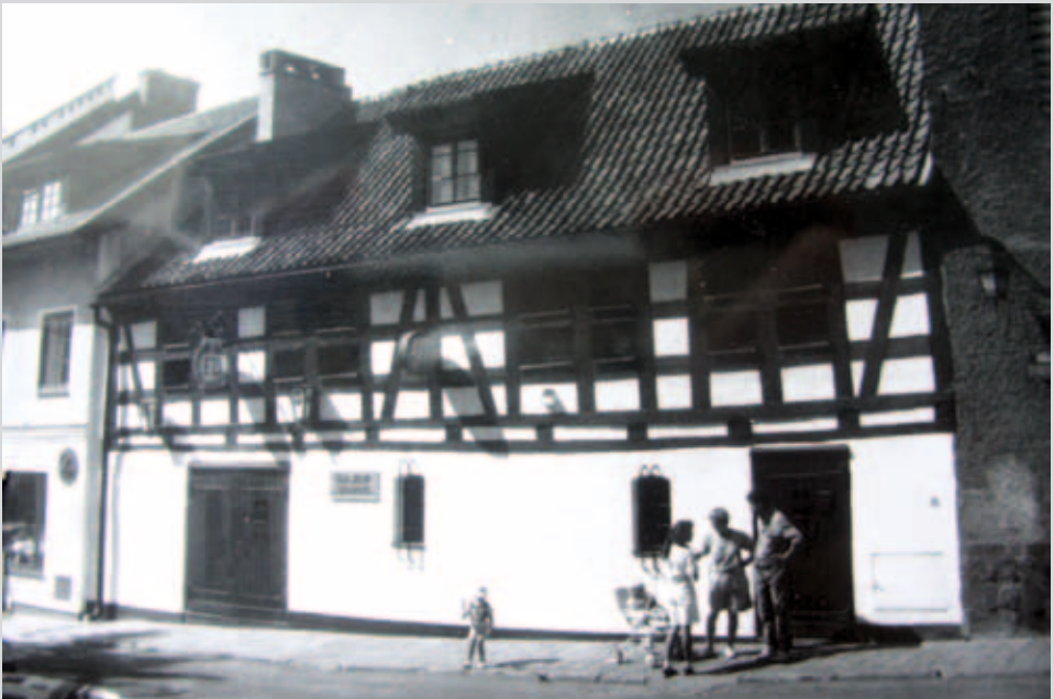
Spichlerz przy ul. Kołłątaja 14. Zdjęcie archiwalne elewacji frontowej ze zbiorów WUOZ w Olsztynie, tzw. karta adresowa (fiszka), oprac. W. Knercer, 1995 r. (zdjęcie najprawdopodobniej pochodzi z lat 80. ubiegłego wieku)
