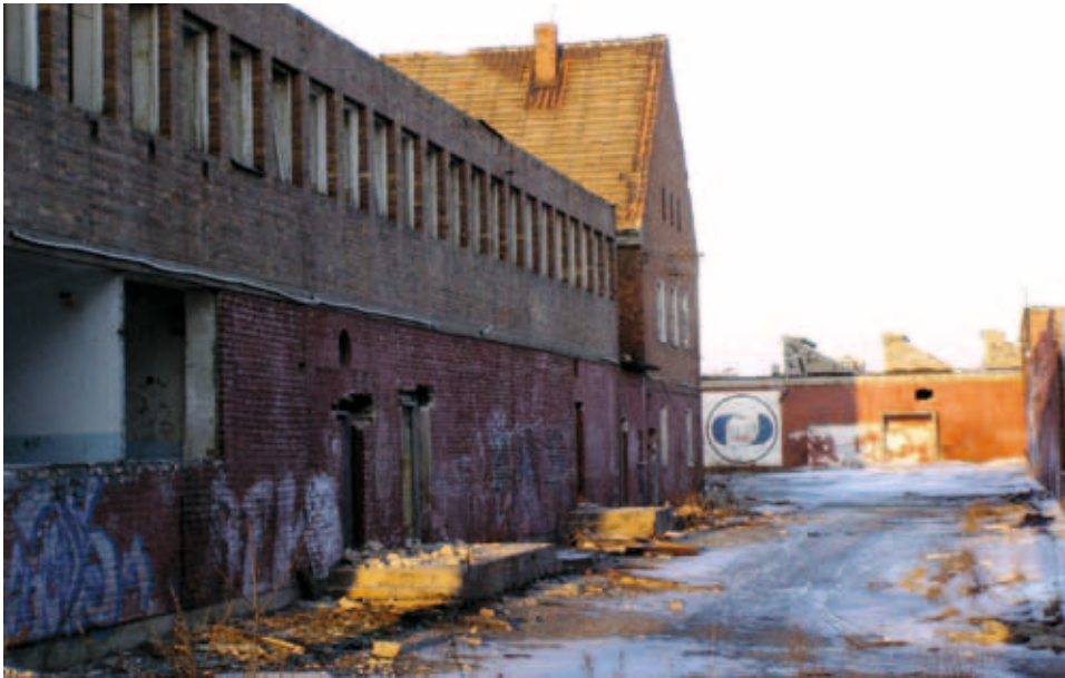
Budynki zespołu rzeźni przed rozbiórką, w głębi – fragment hali głównej z dachem szedowym (stan z 2003 r., obecnie budynki nie istnieją). Zdjęcie udostępnione przez stronę www.moje-fotografie.olsztyn.pl
