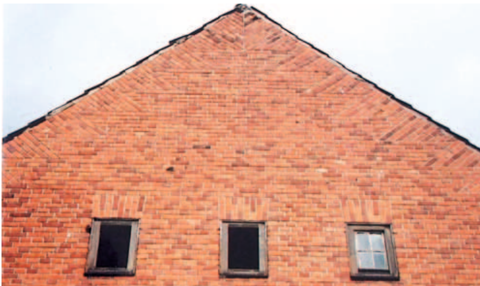
Dekoracyjnie opracowany poprzez ukośne ułożenie cegieł detal szczytu dawnego budynku administracyjnego rzeźni (stan z 2002 r. , obecnie nie istnieje). Fot. J. Liżewski
