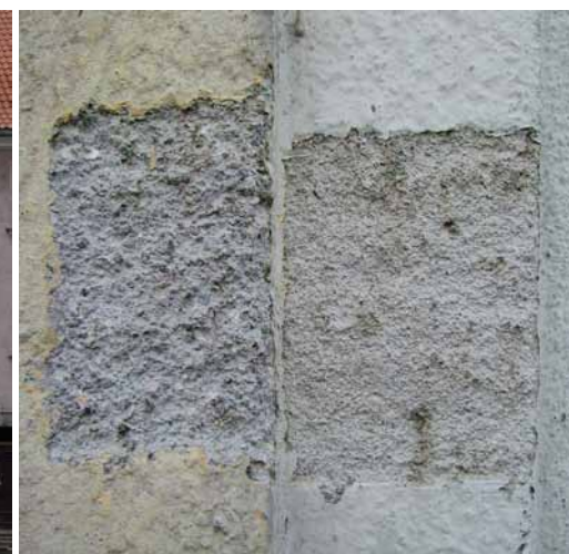
Budynek przy ul. Grunwaldzkiej 23. Oryginalna faktura tynków na elewacji frontowej, w odkrywce po lewej – na tle, w odkrywce po prawej – na obramieniu okna.
