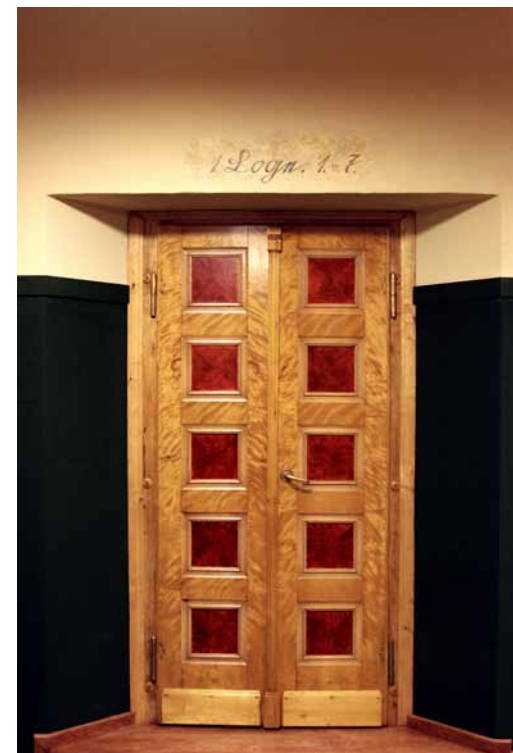
Stolarka drzewiowa do Sali Dużej – po renowacji. W płycinach odtworzono kolor smoczjej krwi dodawanej pierwotnie do politury. Napis nad wejściem po konserwacji.
