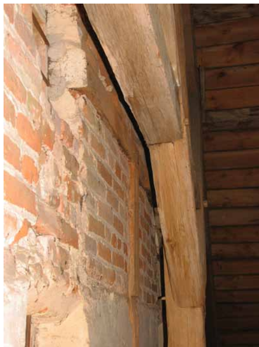
Relikty pierwotnej więzby dachowej (storczyk i jętką) zachowane we wschodnim szczycie kościoła św. Wawrzyńca w Gutkowie.
