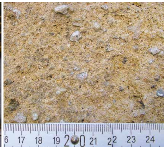
Szeregowiec przy ul. Reymonta 6-8-10, oraz fragment oryginalnego tynku na elewacji budynku.
