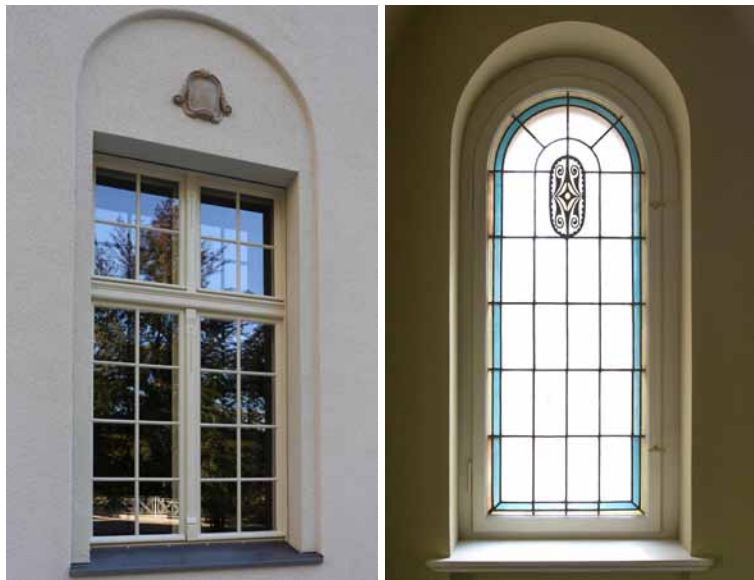
Parter, okna frontowe – wyposażone w roletę okno reprezentacyjne i mniejsze przy wejściu – secesyjny witraż nie utracił nawet jednej szybki.
