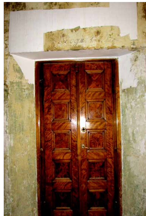
Stolarka drzewiowa Sali Dużej – stan przed renowacją. Skrzydła wykończone obłogiem brzożowym, politurowane, wtórnie pokryte lakierem, który pociemniał. Nad nimi odsłonięty napis mówiący o lokalizacji miejsc na tej łoży, do której prowadzą dane drzwi.
