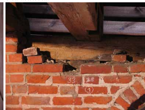
Słup i oczep szkieletowej ściany dziedzicznej południowego skrzydła zamku, obmurowanej już w późnym średniowieczu.
