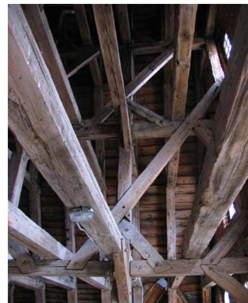
Usztywnienie podłużne wieżby dachowej północnego skrzydła zamku.
