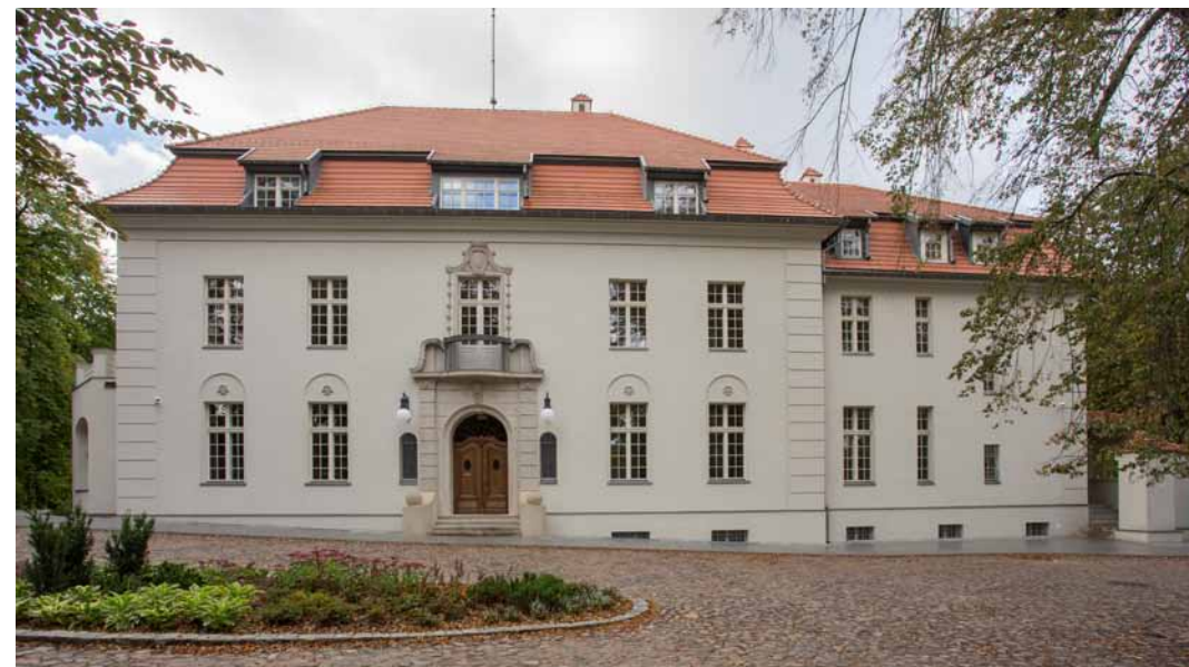
Zachowana w 100% elewacja północna po konserwacji.
