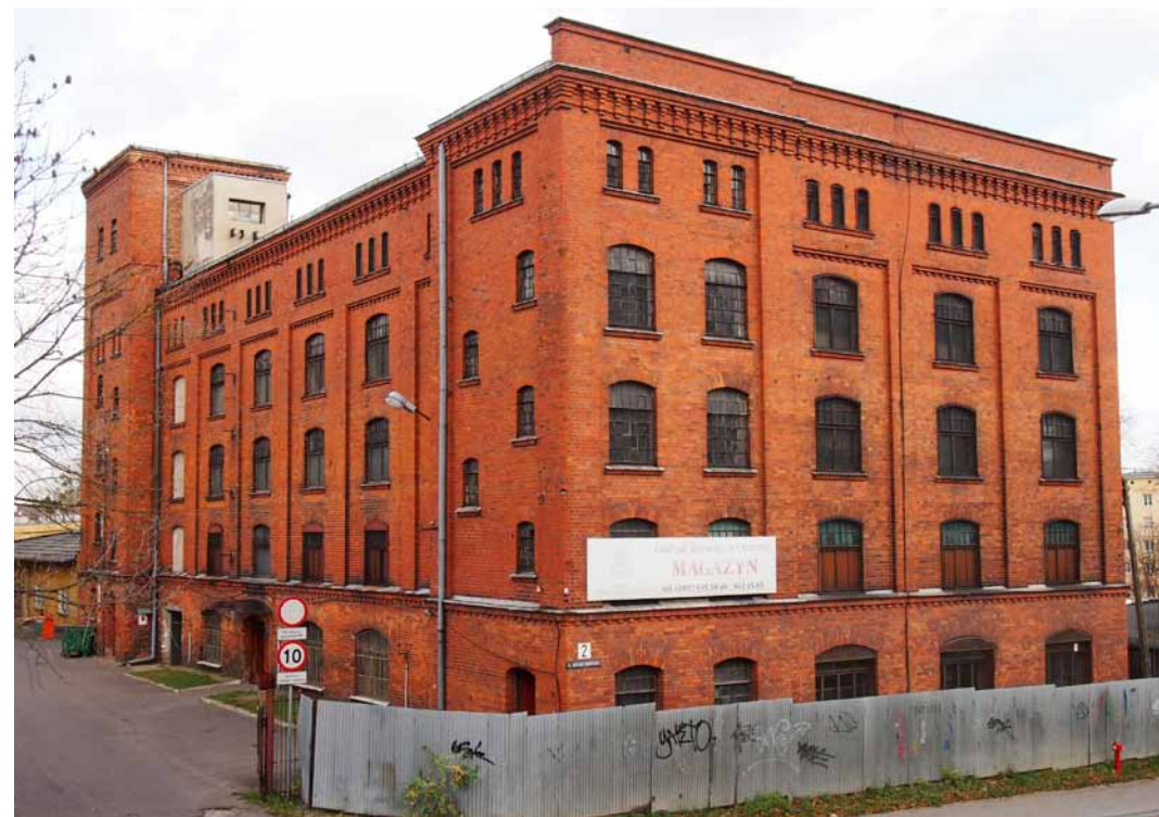
Magazyn z zespołu Urzędu Prowiantowego przy ul. Dąbrowskiego, obecnie w użytkowaniu Agencji Mienia Wojskowego.
