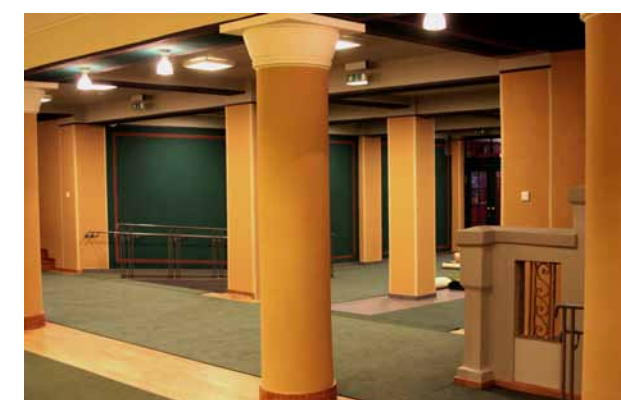
Hol Główny i Foyer – widok po rekonstrukcji. Na podstawie zachowanych śladów i fotografii archiwalnej odtworzono m.in. kolory, kapitele kolumn, podział kasetonowy sufitu. Słupy i lizeny zostały poszerzone ze względów konstrukcyjnych.
