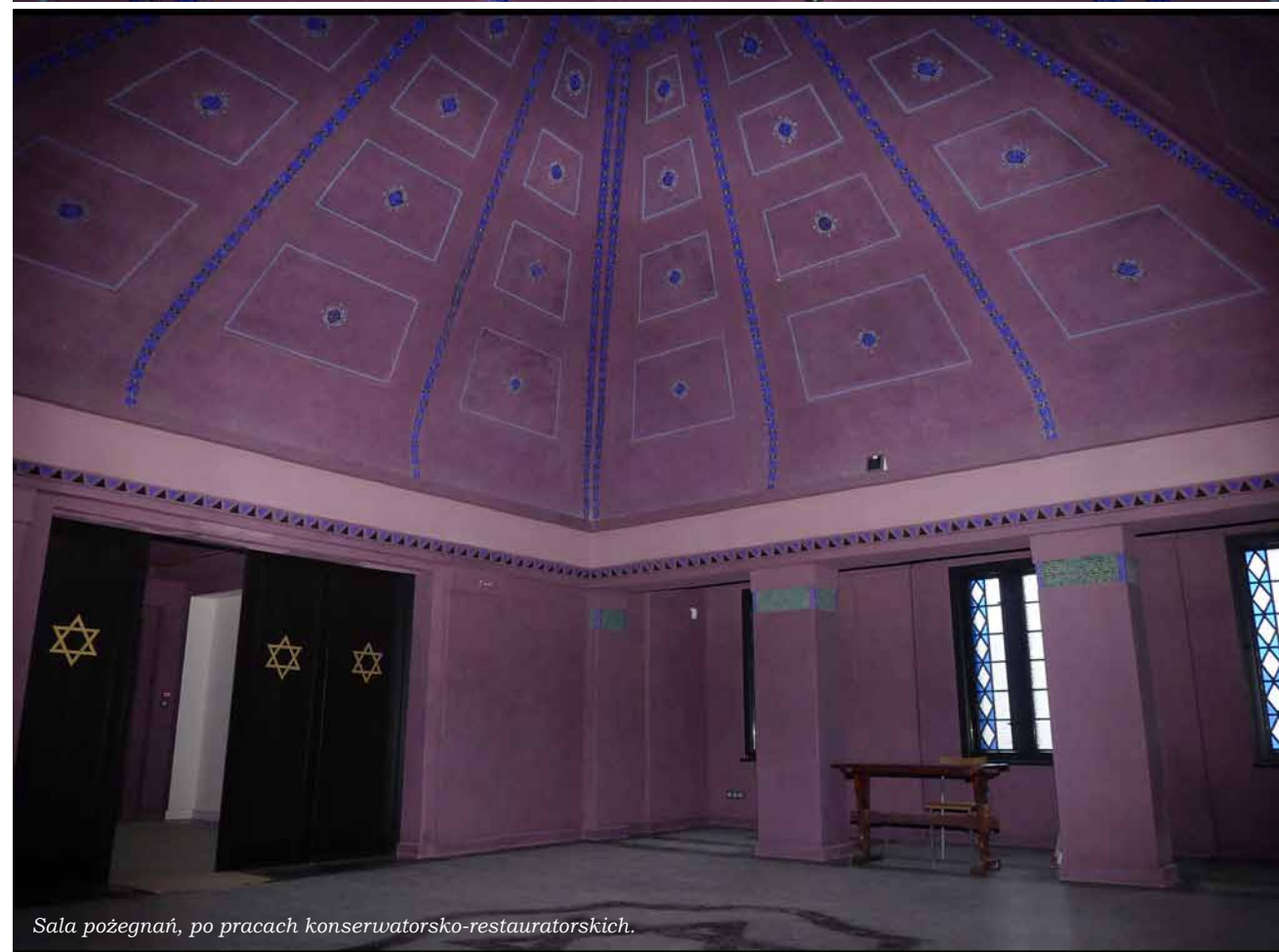
Pseudosklepienie w sali pożegnań, po pracach konserwatorsko-restauratorskich.
