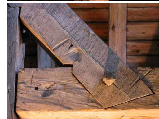
Złącza ciesielskie na nakładkę zaczepową oraz znaki montażowe wieżby dachowej północnego skrzydła zamku.
