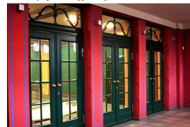
Hol Kasowy – po rekonstrukcji kolorystyki. Oryginalne przeszklone drzwi wahadłowe po rekonstrukcji kolorystycznej.
