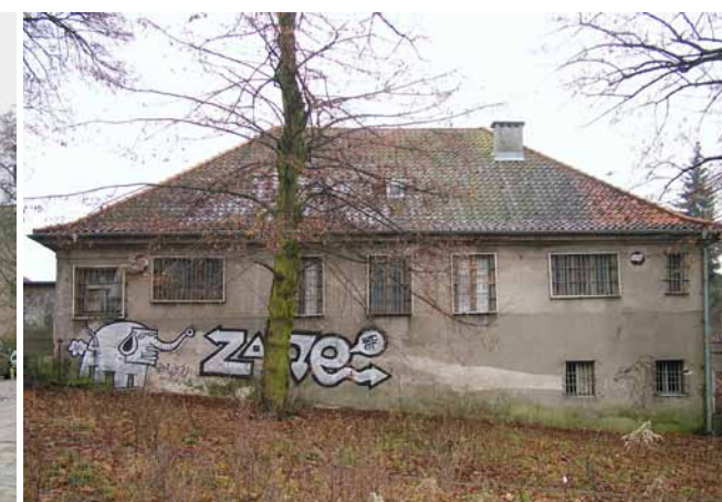
Elewacja tylna, stan w 2009 r.
