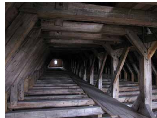
Wieżba dachowa północnego skrzydła zamku.
