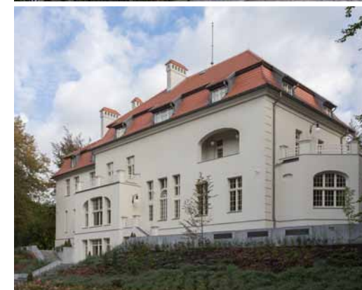
Widok od południowe- go wschodu 1913 r. 2 i 2013 r. W przyziemiu pojawiło się wejście do restau- racji o podziałach wzorowanych na zamkniętym łukiem koszowym oknie jadal- ni. Powróciły również kominy odtworzone na podstawie stule- tnich fotografii – kryją w swoim wnętrzu czepnie i wyrzutnie powietrza oraz spalin.
