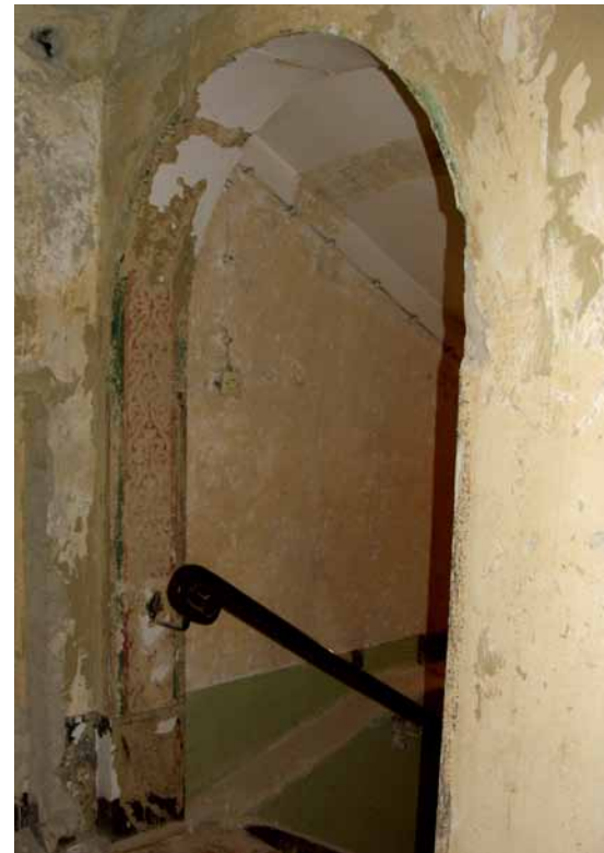
Podłucze przy schodach prowadzących do piwnicy. Po odsłonięciu przemaalowań uwidocznił się wzór plecionkowy oraz podziały pasowe na krawędziach. W dolnej partii zdjęcia zachowany pochwył balustrady schodowej.
