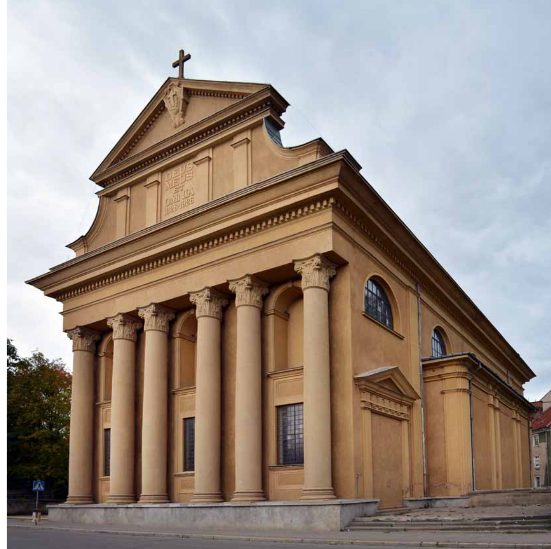
Kościół usytuowany przy ul. Wyspiańskiego, widok na fasadę i elewację wschodnią.
