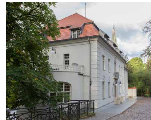
Widok od mostu zamkowego 1913 r. 2 i 2013 r. Po długiej nieobecności powróciło na swoje miejsce trzecie okno podnoszone w pokoju pod tarasem – wiernie zrekonstruowane na podstawie zachowanych egzemplarzy.
