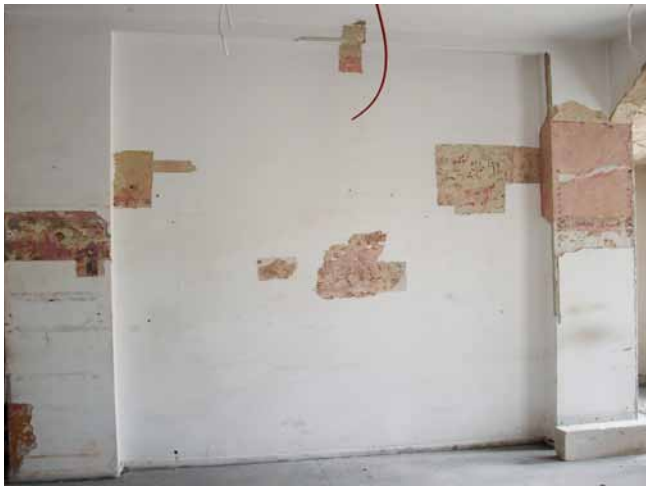
Dawna Sala Restauracyjna – część stanowiąca obecnie pomieszczenie kas i biura obsługi widza. Widoczne odkrywki wskazujące na zachowany złożony wzór na ścianie.
