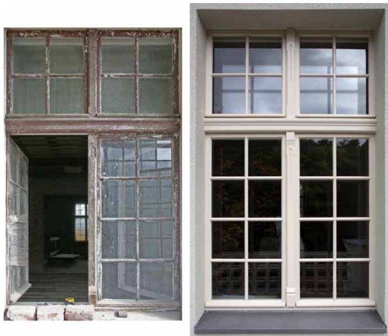
Oryginalne okno piętra przed i po konserwacji. Pierwotnie posiadało rozwierane i uchylne okiennice.
