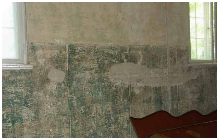
Ściana na Foyer Sali Dużej po odsłonięciu z wtórnych warstw. Widoczne odbite ślady przyklejonego na wysokości lamperii pierwotnego płótna w kolorze zieleni.
