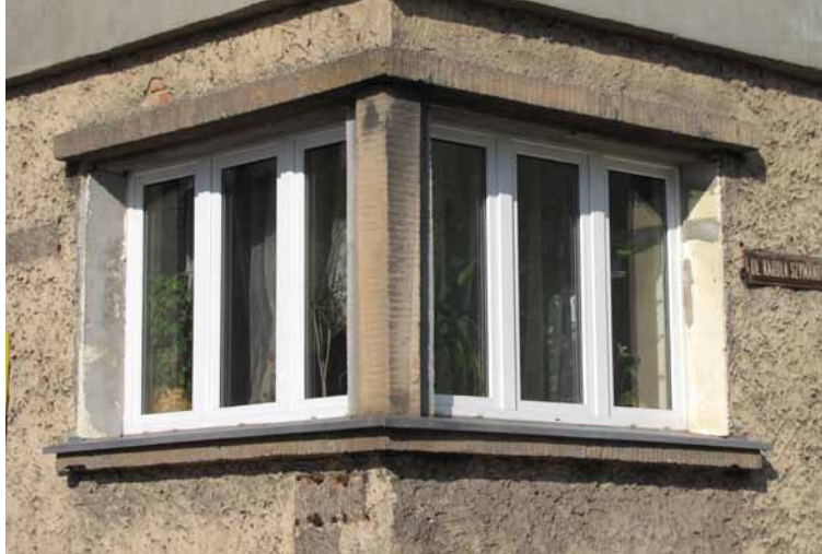
Charakterystyczne dla modernizmu okno narożne, z oszczędną, ale wyrazistą plastyką obramowań.
