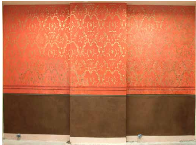
Dawna Sala Restauracyjna – część stanowiąca obecnie pomieszczenie biura promocji. Widok po konserwacji i rekonstrukcji podłoża, dekoracyjnego detalu oraz złożonego wzoru na ścianie.
