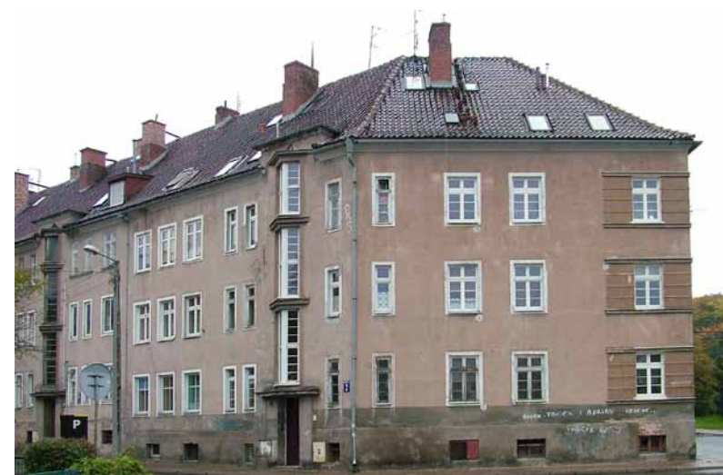
Szeregowiec przy ul. Sienkiewicza 2 – stan obecny.
