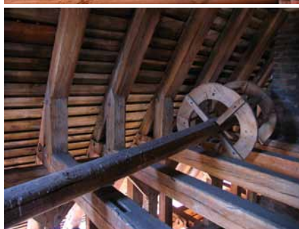
Dawny kołowrót zachowany na poddaszu południowego skrzydła zamku.
