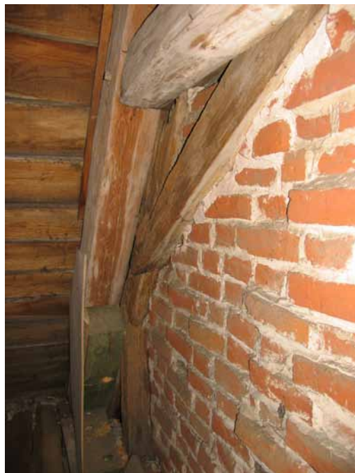
Relikty średniowiecznej więzby dachowej zachowane w zachodniej ścianie szczytowej kościoła św. Wawrzyńca w Gutkowie
