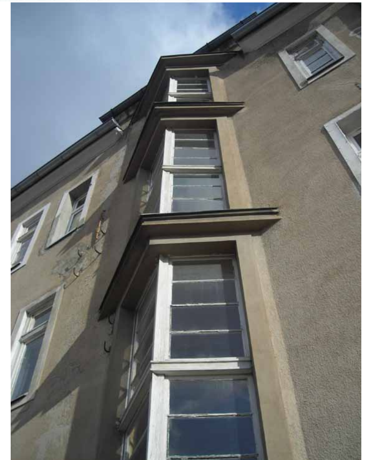
Ryzalit klatki schodowej w bloku zabudowy przy ul. Sienkiewicza (dzielnica Zatorze).
