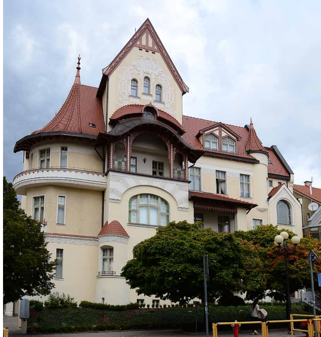
Fasada kamienicy przy ul. Dąbrowszczaków 3, siedziby Miejskiego Ośrodka Kultury.
