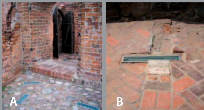
6. Toruń – ruiny zamku krzyżackiego po zainstalowaniu podświetlenia murów. Rzucające się w oczy źle dobrane, o kształtach sprzecznych z nawierzchnią i źle rozmieszczone elementy oświetlenia. A – liczne lampy w bruku dziedzińca. B – liczne lampy w posadzkach pomieszczeń, a nawet na uczytelnionym murze działowym.
