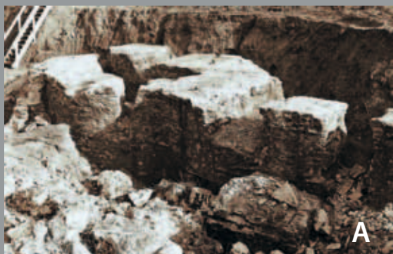
9. Wrocław. Zewnętrzna Brama Oławska. Relikty muru piattaformy – stan w 1974 r. i po restauracji. A. Relikty muru piattaformy odsłonięte w 1974 r. na pasie terenu zaprojektowanej przez miasto, staromiejskiej obwodnicy drogowej Wrocławia. Widok od strony zachodniej na tylny mur konstrukcyjny bastionu z XVI w. (linia falista) i po prawej stronie – kubiczny mur przyczółka mostowego z początku XIV w. (fot. z archiwum badań). B. Mur piattaformy we wnętrzu podziemnego przejścia i mur przyczółka mostowego w głębi – po konserwatorskiej restauracji (fot. M. L. Lewicka, 2011).
