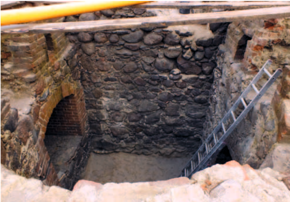
10. Widok wnętrza zachowanej piwnicznej kondygnacji baszty.
