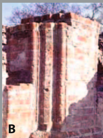
4. Toruń – ruiny zamku krzyżackiego. Fragment krużganków. A – przed założeniem izolacji. B – po założeniu izolacji i nadmurowaniu jednej warstwy cegieł.
