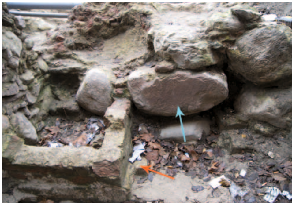
6. Skrzynia fundamentowa widoczna u zbiegu muru niskiego oraz wschodniej ściany szyi bramnej.
