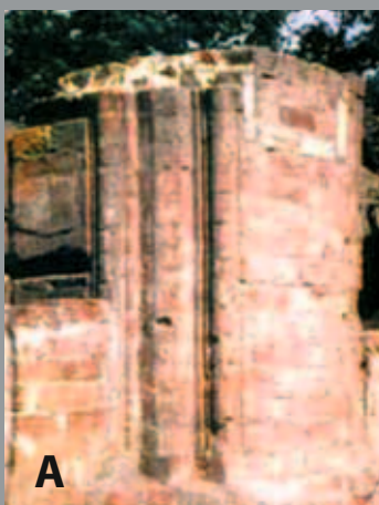
4. Toruń – ruiny zamku krzyżackiego. Fragment krużganków. A – przed założeniem izolacji. B – po założeniu izolacji i nadmurowaniu jednej warstwy cegieł.
