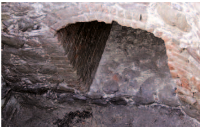
19. Olsztyn, st. XXIV, wykop 110. Fragment ściany wewnętrznej z wnęką strzelniczą. Fot. A. Mackiewicz.
