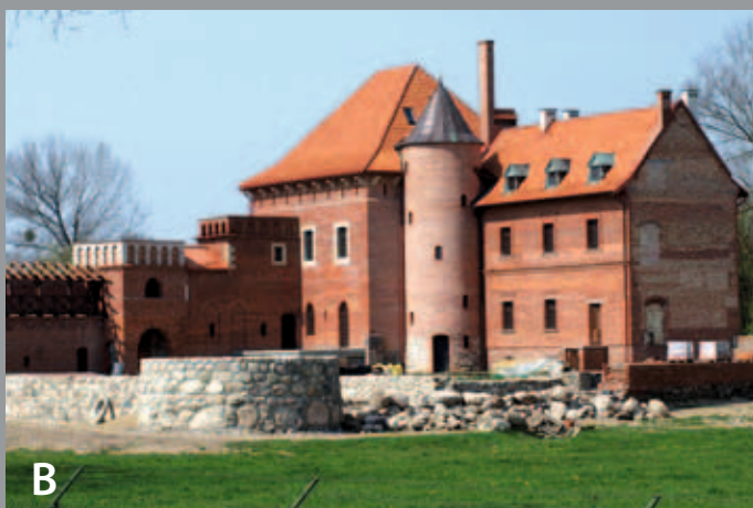
2. Tykocin. A – ruiny zamku, który został rozebrany na przełomie XVII i XVIII wieku. B – współczesna odbudowa zamku.
