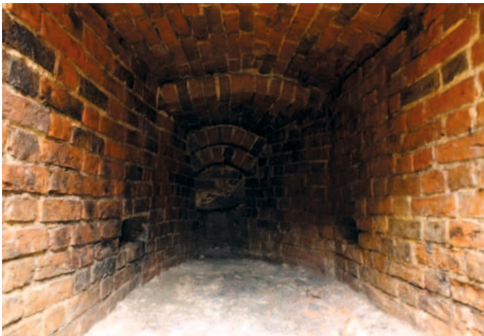
8. Widok wnętrza wschodniej strzelnicy. Po bokach widoczne symetryczne gniazda ryglów.
