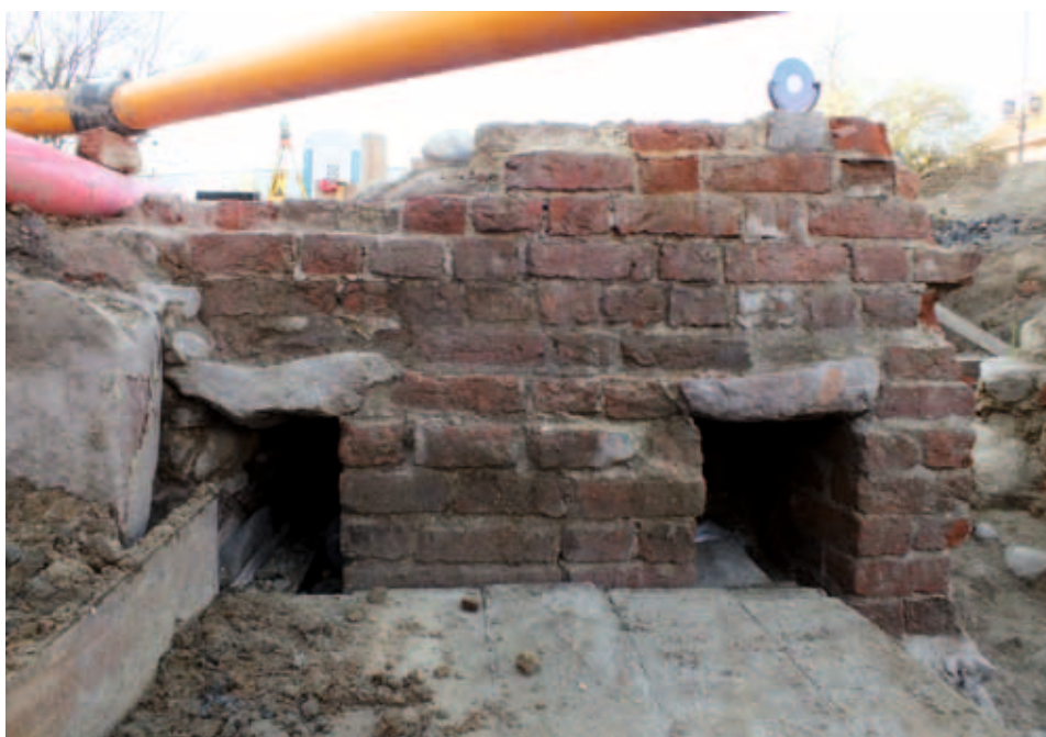
9. Widok gniazd po belkach drewnianego stropu międzykondygnacyjnego.
