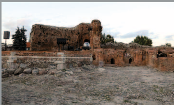
5. Toruń – ruiny zamku krzyżackiego po zainstalowaniu urządzeń dla nowego programu „światło i dźwięk”. Wieża „udekorowana” aparaturą rzucającą się w oczy po wejściu w ruiny.
